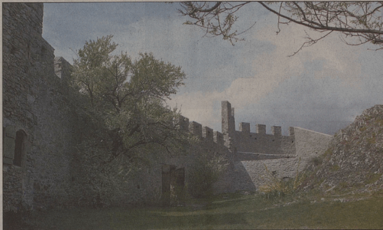
Des travaux de consolidation ont été entrepris à Tourbillon.
